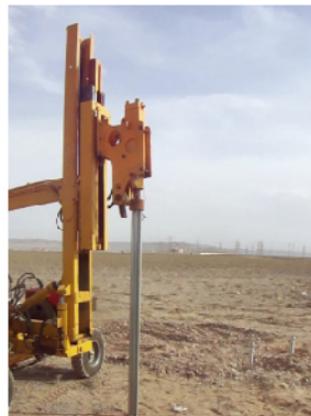
锤入桩现场施工测试
