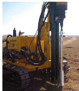
螺旋桩现场施工测试
